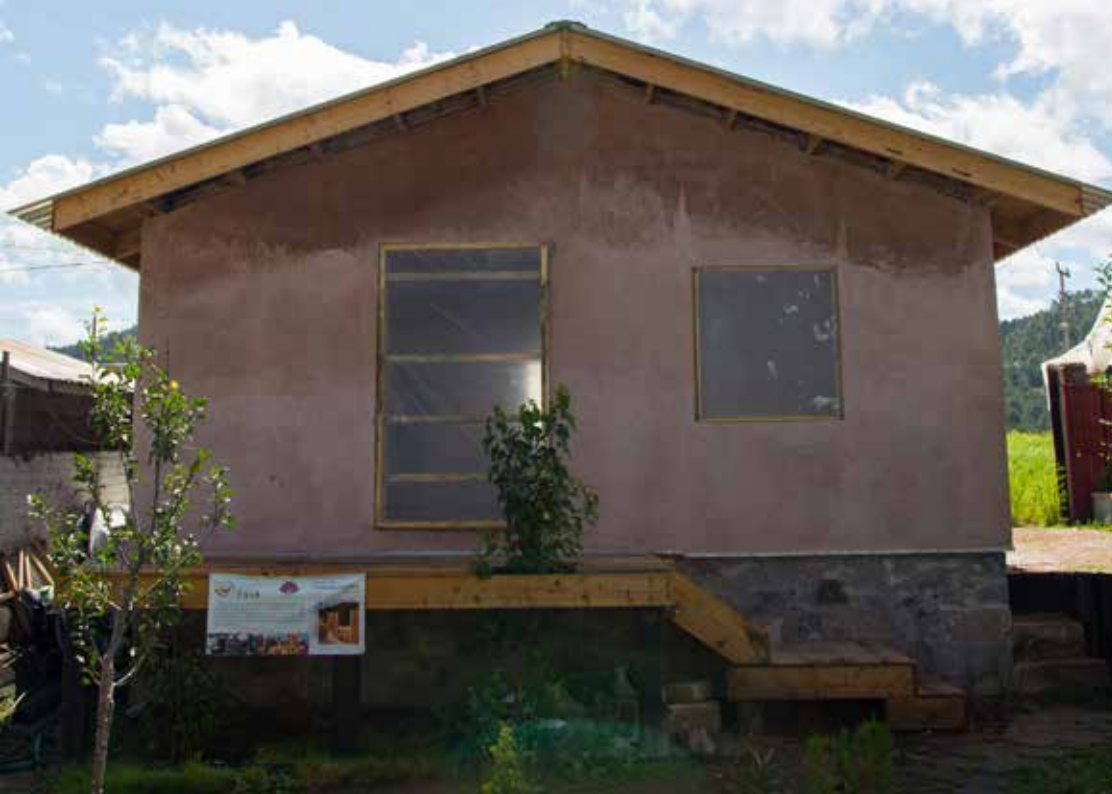
Construcción de un salón con pacas de paja
